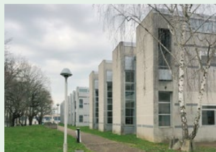
État actuel du bâtiment
