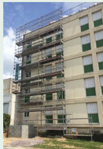
État actuel du bâtiment
