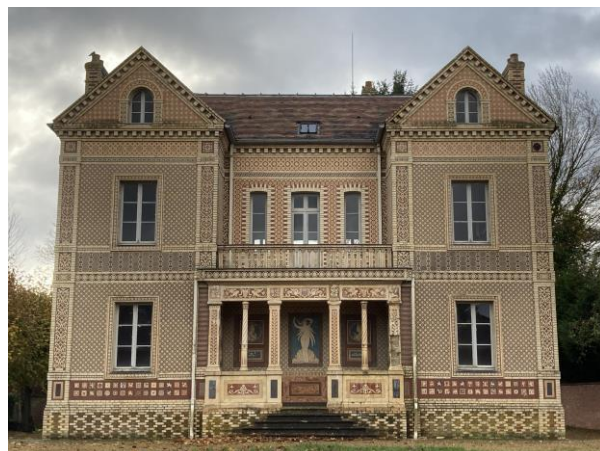
Maison Boulenger Auneuil, photographiée dans le cadre du projet Anamorphose « Les logements de l'industrie » (Source : Florence Hachez-Leroy).
