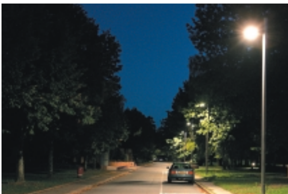
Éclairage de la voie centrale.
